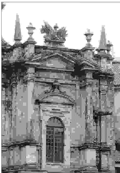
Coronamiento de la calle lateral.
