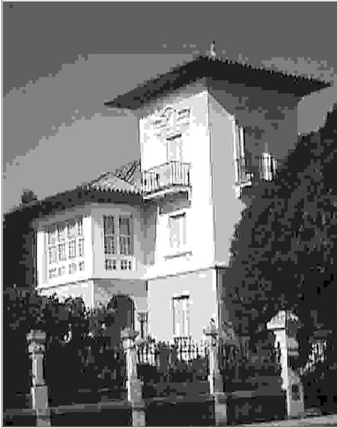
Torreón e galería.
