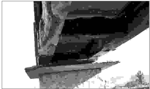
Detalle piso cámara.
