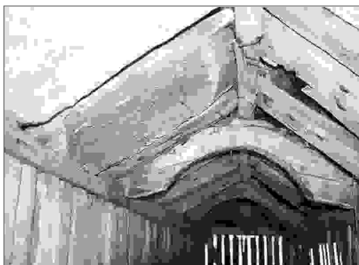
Detalle cubierta interior.
