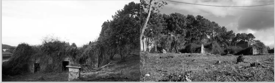
Ilustración 9. Estado actual do casal da Arbosa
