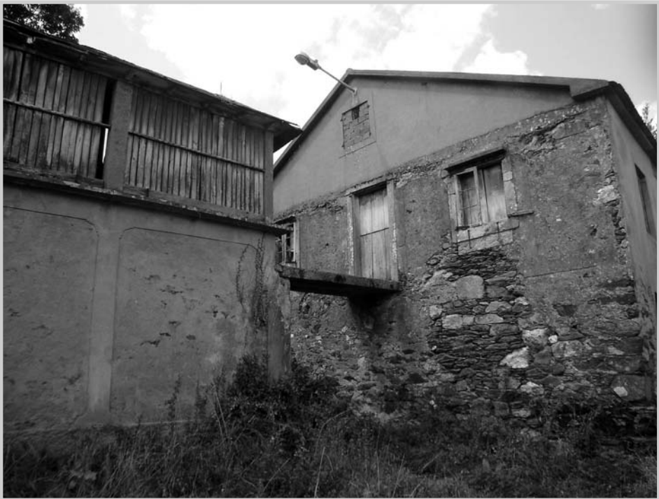
Vista Actual do lugar de Riovello moi reformado. foto do autor
