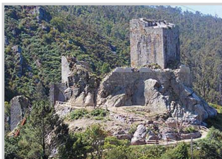
Castelo de Naraío durante a execución do proxecto de recuperación
