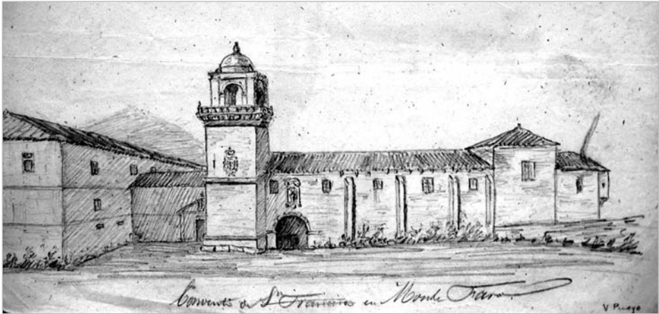
Convento de Montefaro. Vicente Pueyo (c.1859)
